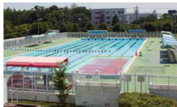
▶新築される戸田市スポーツセンタープール
